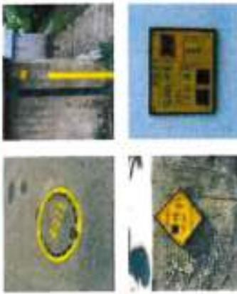
Rețeaua de gaze naturale poate fi identificată după marcaje existente pe reperole fixe (plăcuțe, marcaje cu vopsea etc.); sau în funcție de alte elemente vizuale (bandă de semnalizare a lucrărilor în curs, plăcuțe, marcaje cu vopsea etc.).
